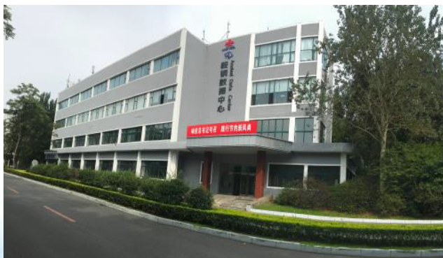
数据中心全景图
